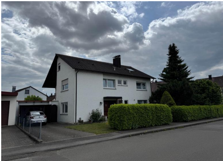
Abb.: Blick von der Mörikestraße auf Wohnhaus, Garage und Vorgarten
