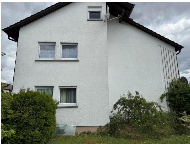
Abb.: Wohnhaus Mörikestraße 9, Ansicht West
