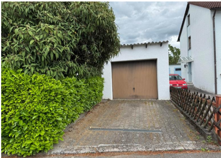
Abb.: Garage im Süden des Grundstücks, Schnitthecke und Gebüsch aus Runzelblättrigem Schneeball
